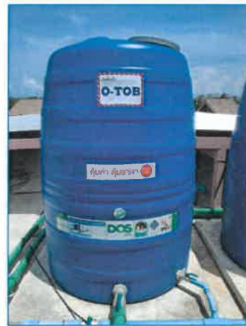
ภาพถ่ายที่ 2.2-8 ถังเก็บน้ำใต้ดินและถังเก็บน้ำชั้นดาดฟ้า
