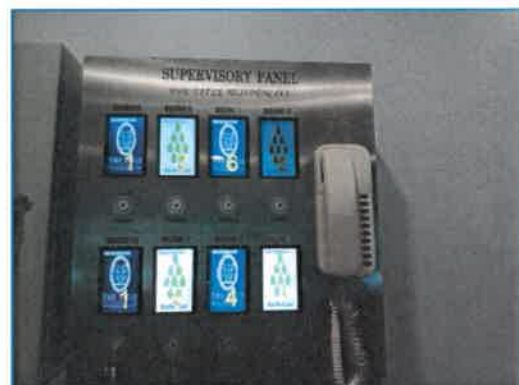
ภาพถ่ายที่ 2.2-22 ตู้ควบคุมระบบแจ้งเตือนป้องกันอัคคีภัย
